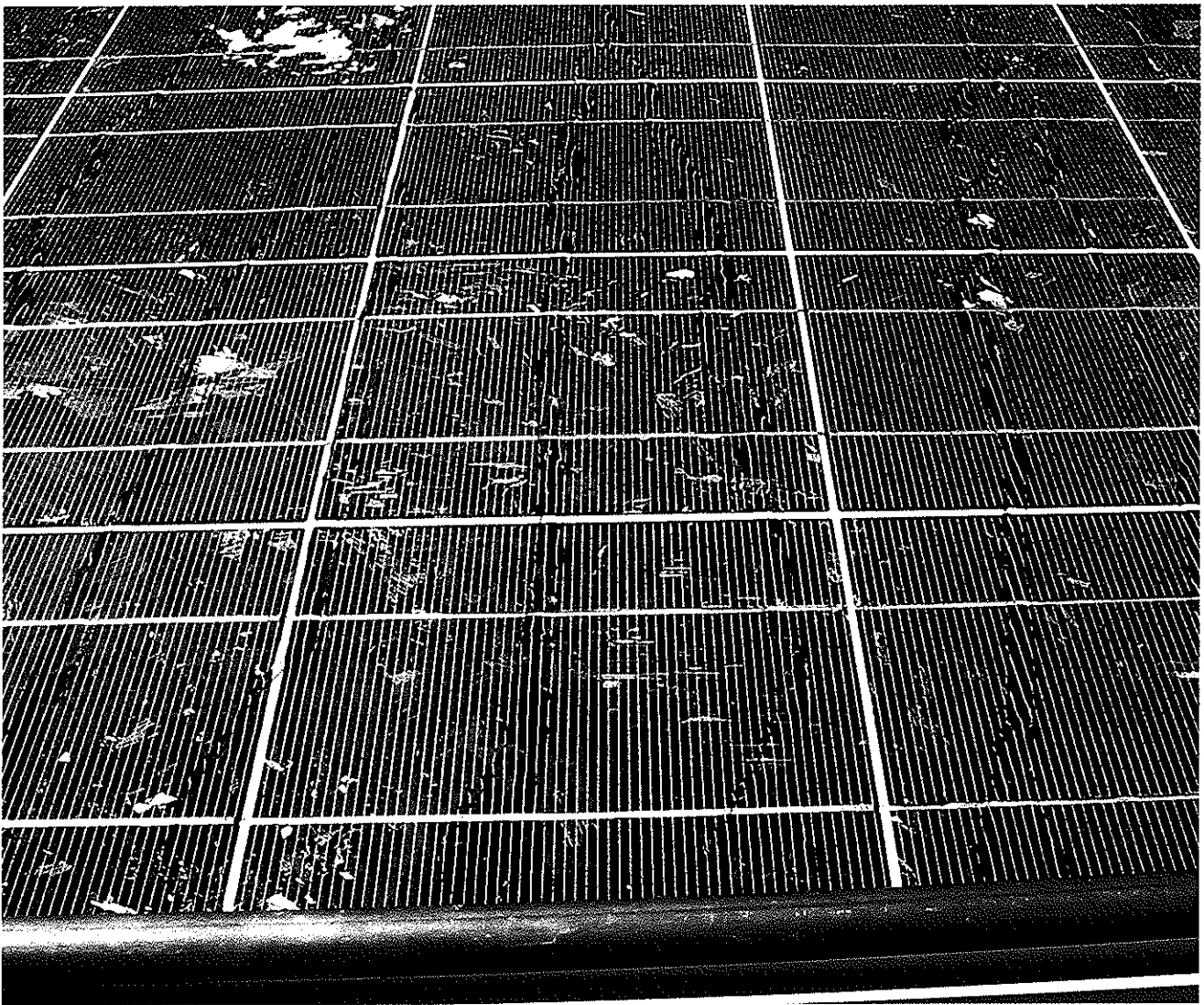
Gracias a la tecnología DTL se reduce la temperatura de los paneles solares.
